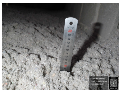
Mesure de l'épaisseur de l'isolant.
