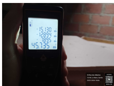
Mesurage de la surface isolée.
