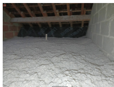
Vue d'ensemble des combles isolés. La pose de l'isolant est homogène.
