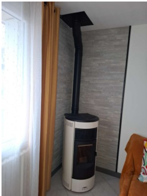
Conduit de fumée 2
