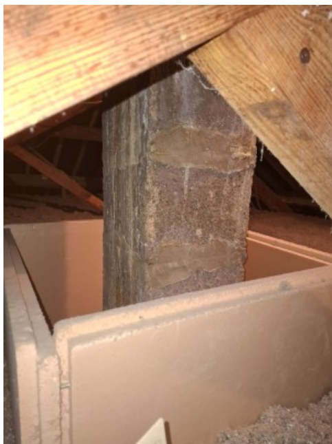
Conduit de fumée 1
